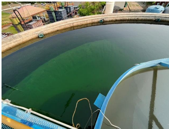
รูปที่ 6 ถังตกตะกอนระบบผลิตน้ำประปาชุดที่ 5
