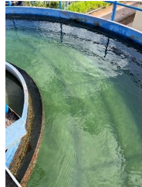
รูปที่ 7 ถังตกตะกอนระบบผลิตน้ำประปาชุดที่ 6-7-8
