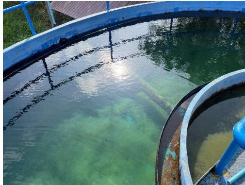
รูปที่ 7 ถังตกตะกอนระบบผลิตน้ำประปาชุดที่ 6-7-8
