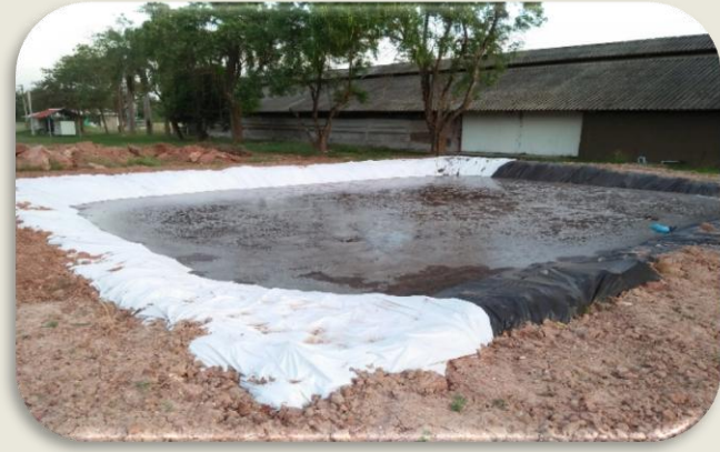
ก่อสร้างบ่อหมักสภาวะกรดและ เติมจุลินทรีย์กลุ่มผลิตกรด
